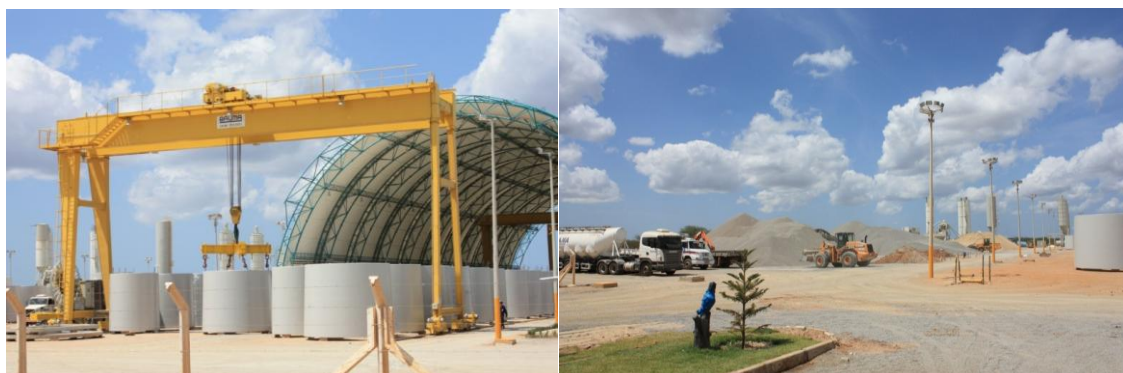
Figura 37 – Foto de fábrica de torres de concreto e insumos armazenados para a preparação de concreto na fábrica
