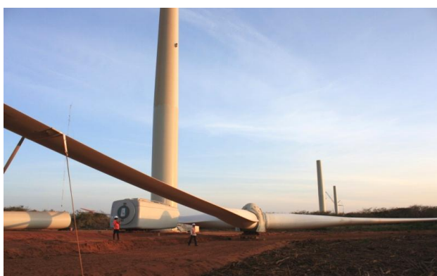
Figura 38 – Foto de montagem de aerogerador
