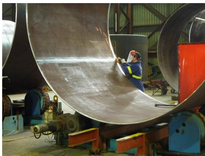
Figura 34 – Fabricação de uma torre de aço
