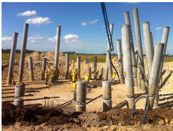
Figura 41 – Foto de construção de uma fundação de aerogerador com estacas
