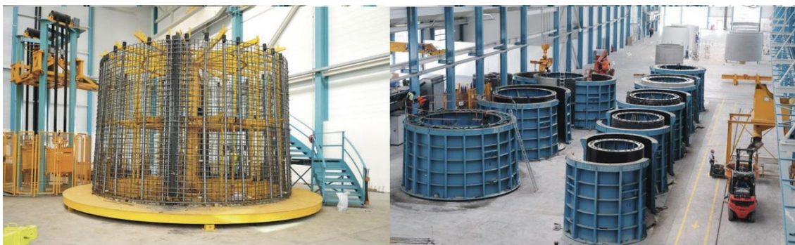
Figura 36 – Fotos da fabricação de uma torre de concreto
