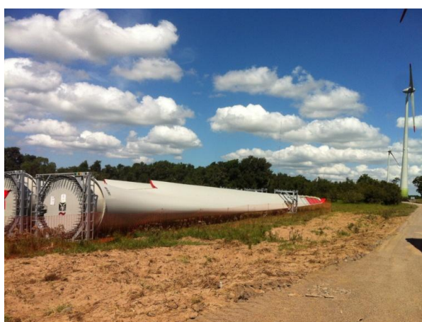
Figura 39 – Foto de pás eólicas armazenadas em local de montagem do aerogerador
