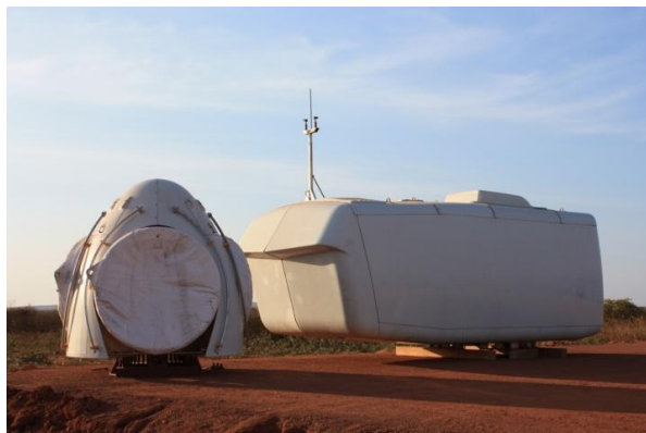
Figura 40 – Foto de nacele e hub armazenados em local de montagem do aerogerador
