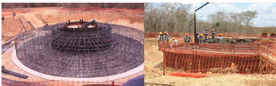
Figura 42 – Fotos da construção de uma fundação de aerogerador sem estacas
