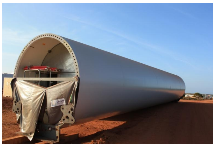
Figura 35 – Foto de segmento de torre de aço armazenada no local de montagem do aerogerador
