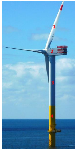
Figura 3 – Componentes de um aerogerador
