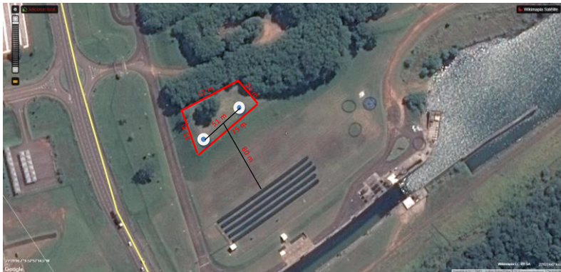
Figura 8 - Área de instalação dos aerogeradores no talude próximo a usina PV rígida de 250 kWp.
